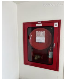
ตู้เก็บสายฉีดน้ำดับเพลิง พร้อมอุปกรณ์
